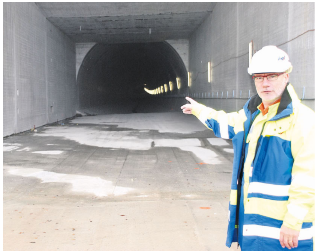
Westportal. Martin Hutter, Chef des Amtes für Nationalstrassenbau, zeigt auf die Südöhre des gedeckten Einschnittes Turtmann.
